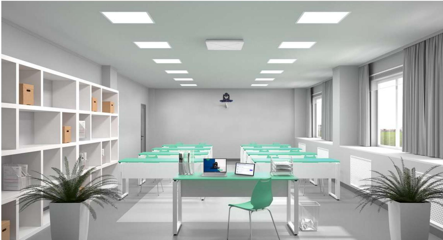
Caméra Kast installée en fixe en fond de salle + Micro dalle plafond + Tablette de contrôle
